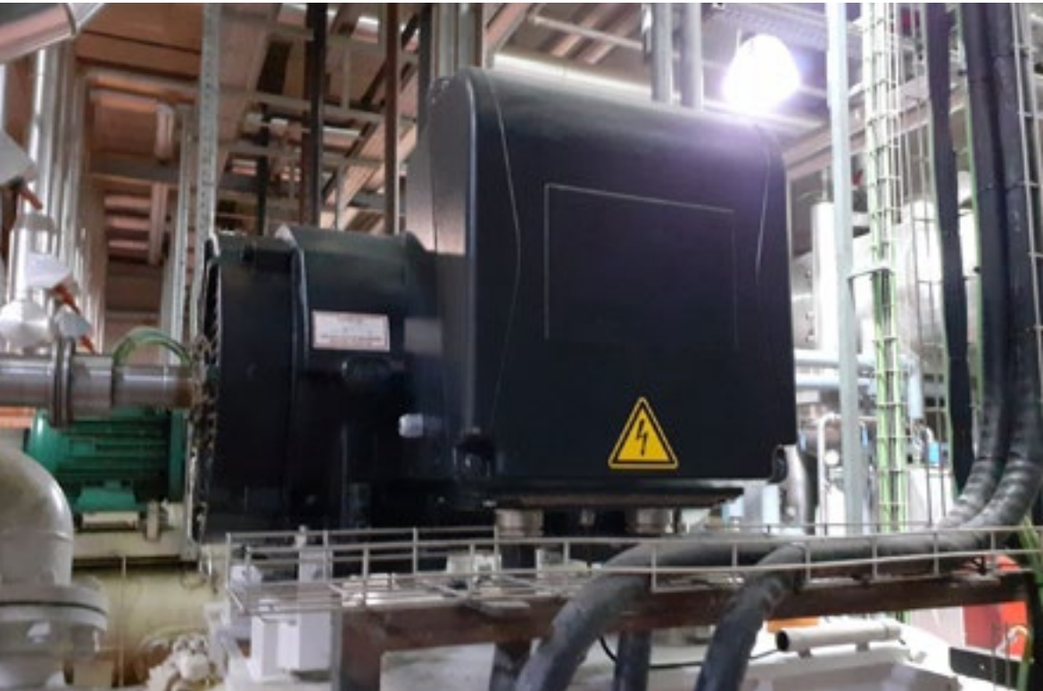
Compressor motor
